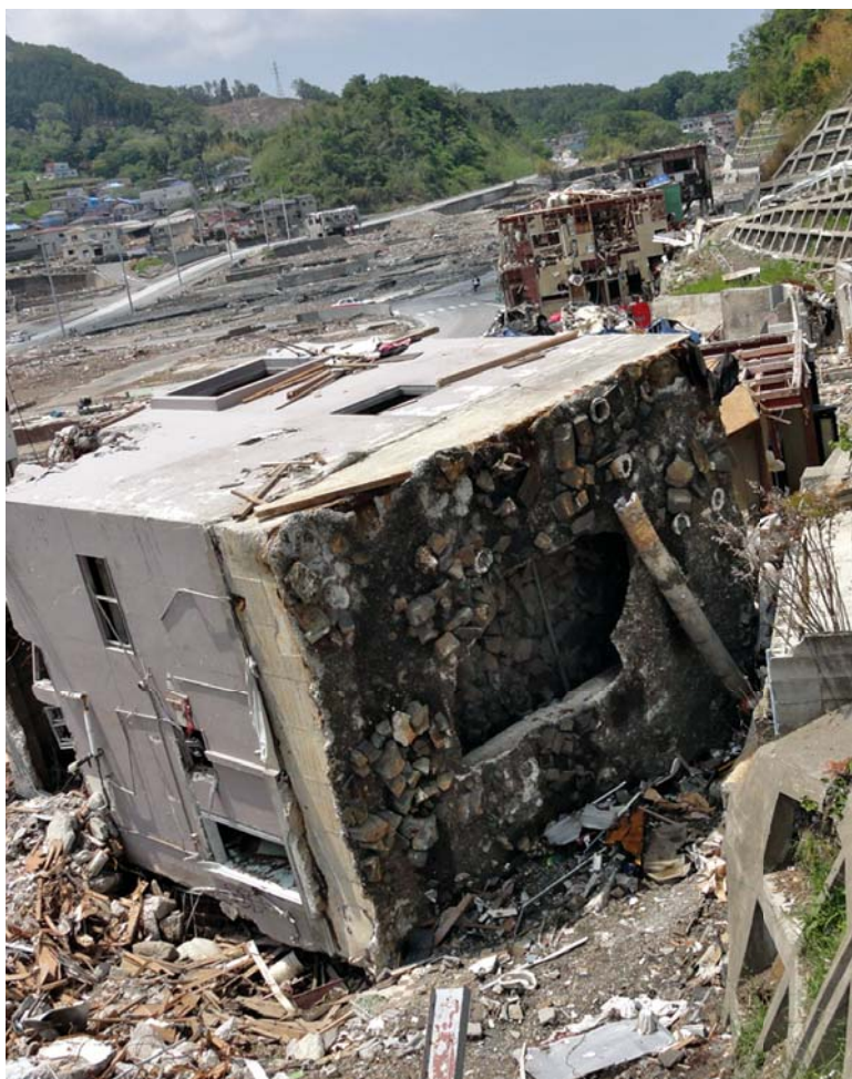
Des masses d'eau atteignant plus de 10 mètres de hauteur et déferlant à plus de 6 mètres par seconde ont renversé et traîné des bâtiments de trois étages sur près de 50 mètres lors du tsunami qui a frappé le Japon le 11 mars 2011
