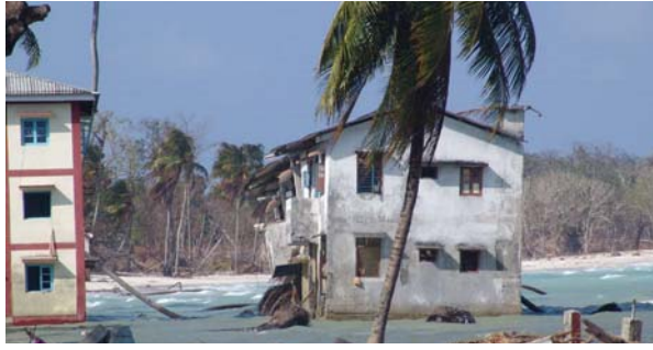
Le séisme du 26 décembre 2004 s'est traduit par une subsidence terrestre de 1,2 m à Car Nicobar, dans les îles Nicobar, en Inde. Des maisons, jadis au-dessus du niveau de la mer, baignent à présent dans l'eau. Crédit photographique : ICMAM, Chennai, DOD, Inde
