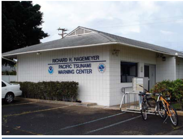
Installations du PTWC à Ewa Beach, Hawaii, États-Unis
